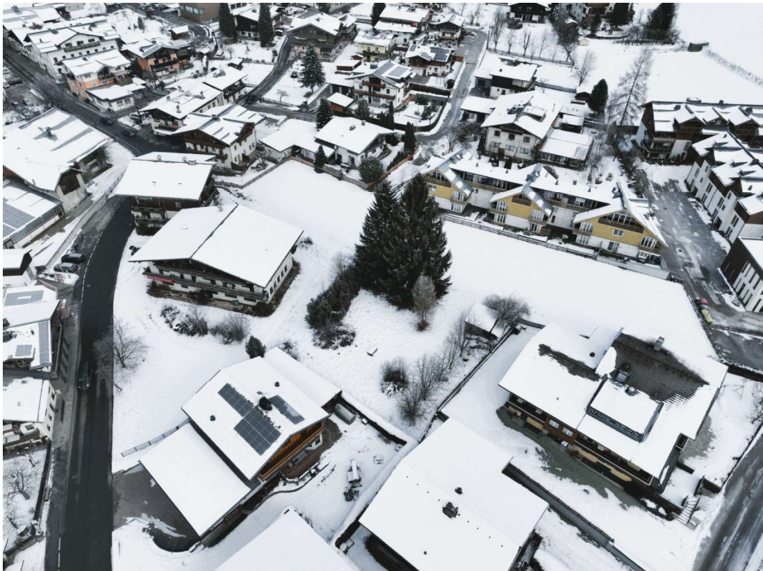
Luftaufnahme von Südwesten mit Zufahrtsstraße links im Bild
