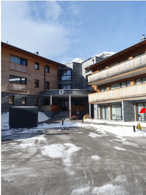
Ansicht von Südosten mit Haupteingang
