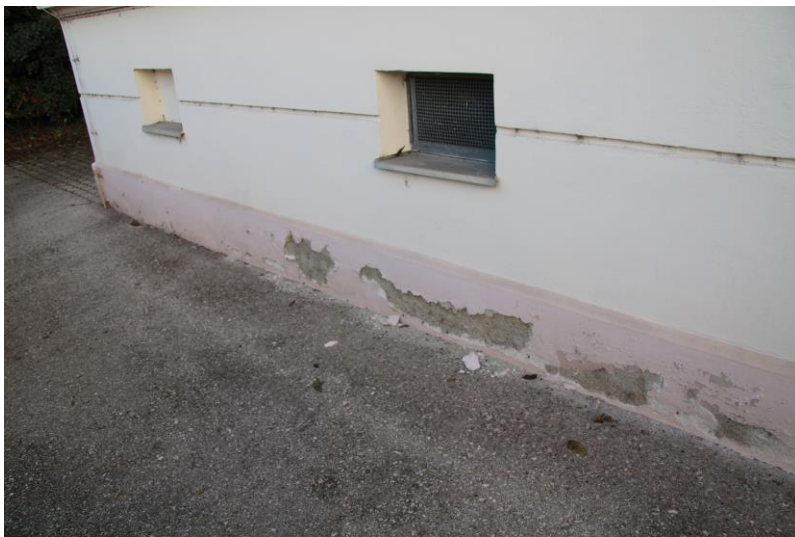
- Schäden im Sockelbereich durch Wasser
