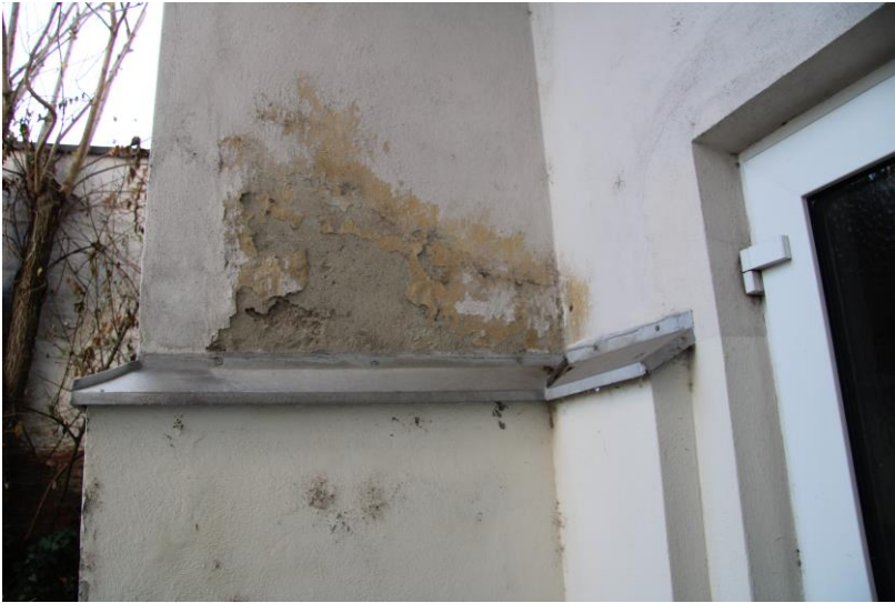
- Schäden im Sockelbereich durch Wasser
