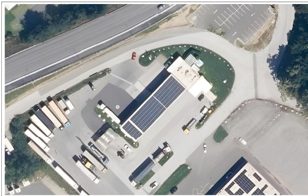
PV-Anlage (Quelle: earth.google.com )
