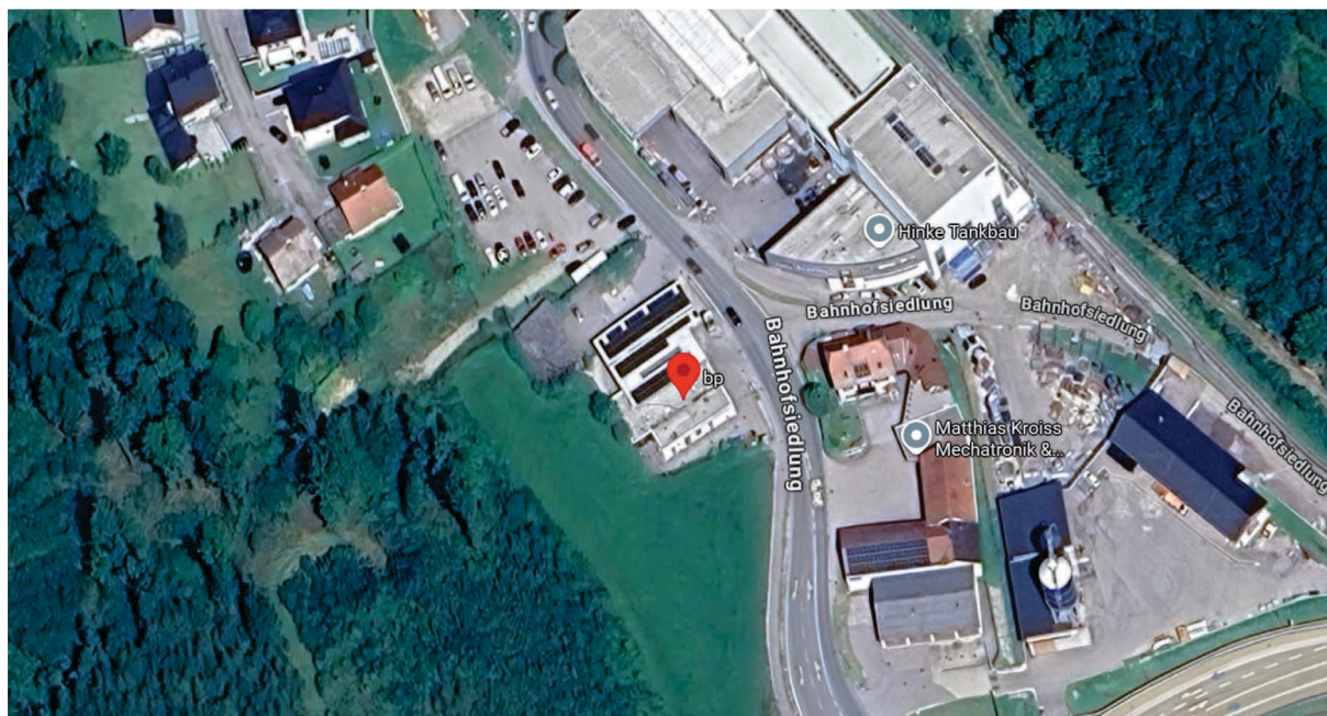
PV-Anlage (Quelle: earth.google.com )
