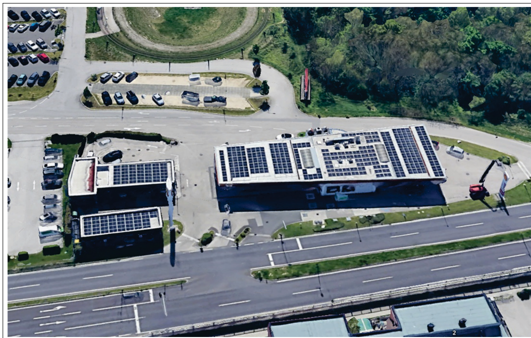
PV-Anlage (Quelle: earth.google.com )
