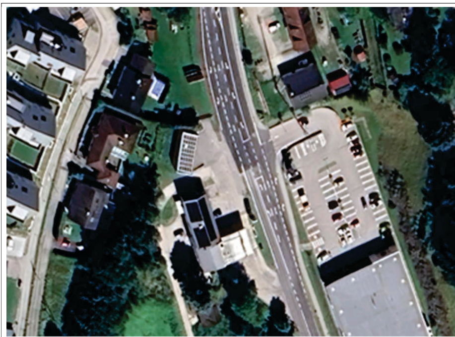
PV-Anlage (Quelle: earth.google.com )
