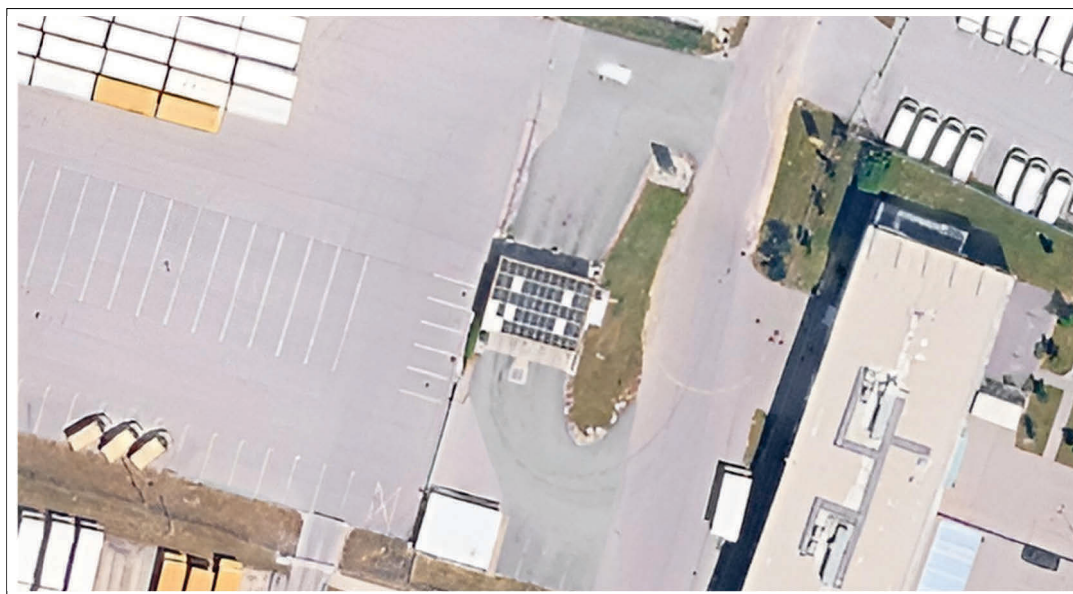
PV-Anlage (Quelle: earth.google.com )
