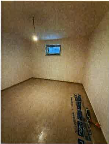
Foto 13: Kellergeschoß Haus Top 2
