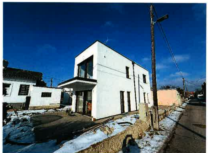
Foto 34: Terrasse & Balkonkonstruktion Haus Top 1
