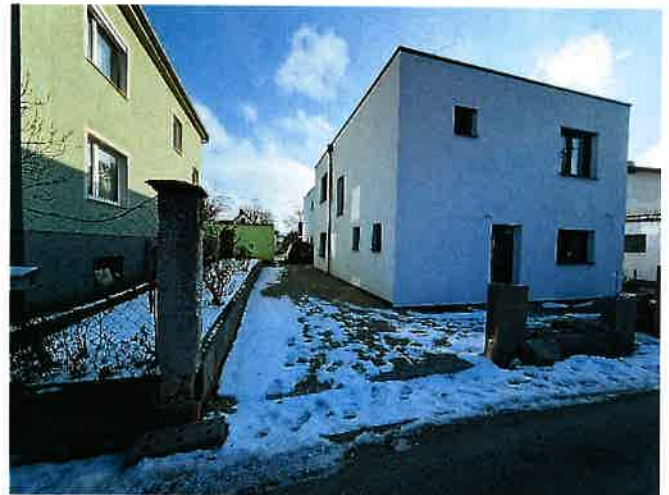
Foto 2: Befestigung Freistellplätze | Fehlende Einzäunung
