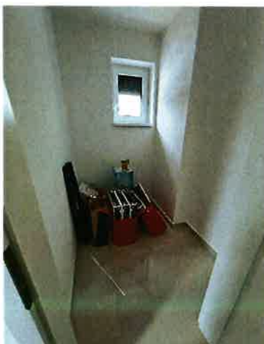
Foto 11: Technik/Lagerraum Haus Top 2
