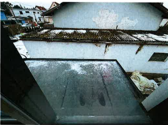
Foto 21: Balkonkonstruktion Obergeschoß Haus Top 2
