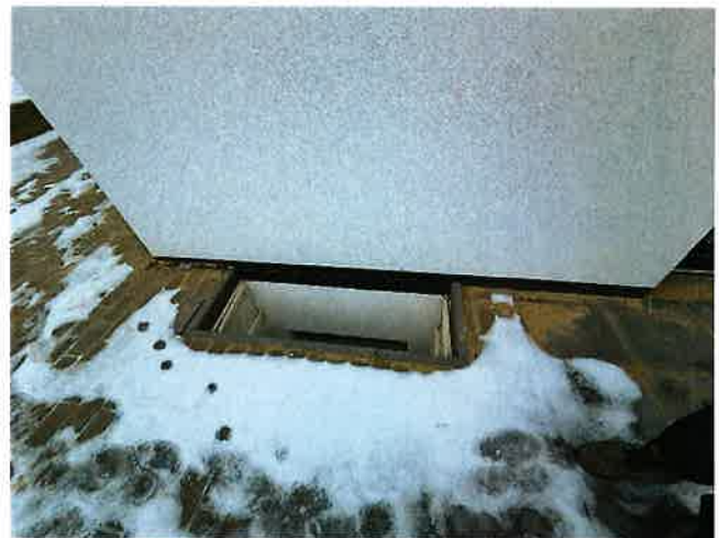
Foto 8: Lichtschacht zum Kellergeschoß Haus Top 2
