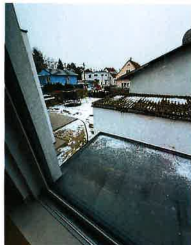
Foto 22: Balkonkonstruktion Obergeschoß Haus Top 2
