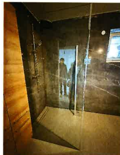
Foto 26: Badezimmer Obergeschoß Haus Top 2
