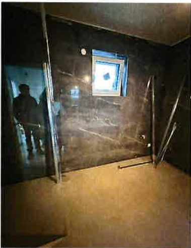
Foto 27: Badezimmer Obergeschoß Haus Top 2
