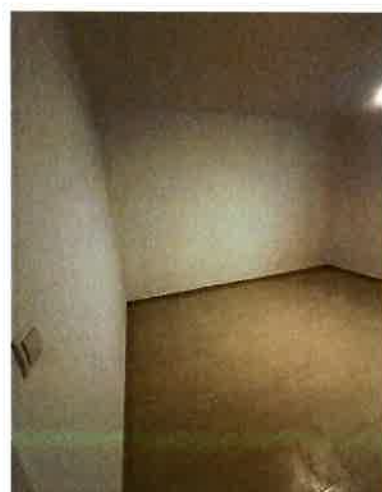
Foto 12: Kellergeschoß Haus Top 2
