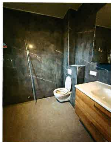
Foto 28: Badezimmer Obergeschoß Haus Top 2
