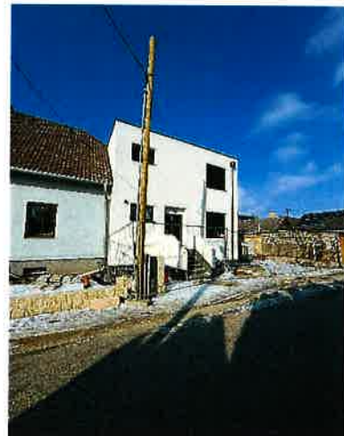
Foto 4: Ansicht Neubau Einfamilienhaus
