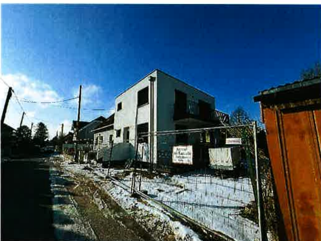
Foto 47: Seitenansicht Neubau Einfamilienhaus
