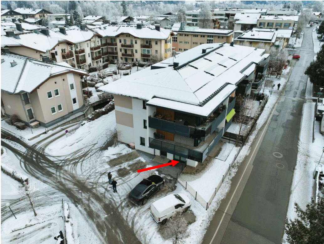
Luftaufnahme von Nordwesten mit Wohnung Top W01 (EG)
