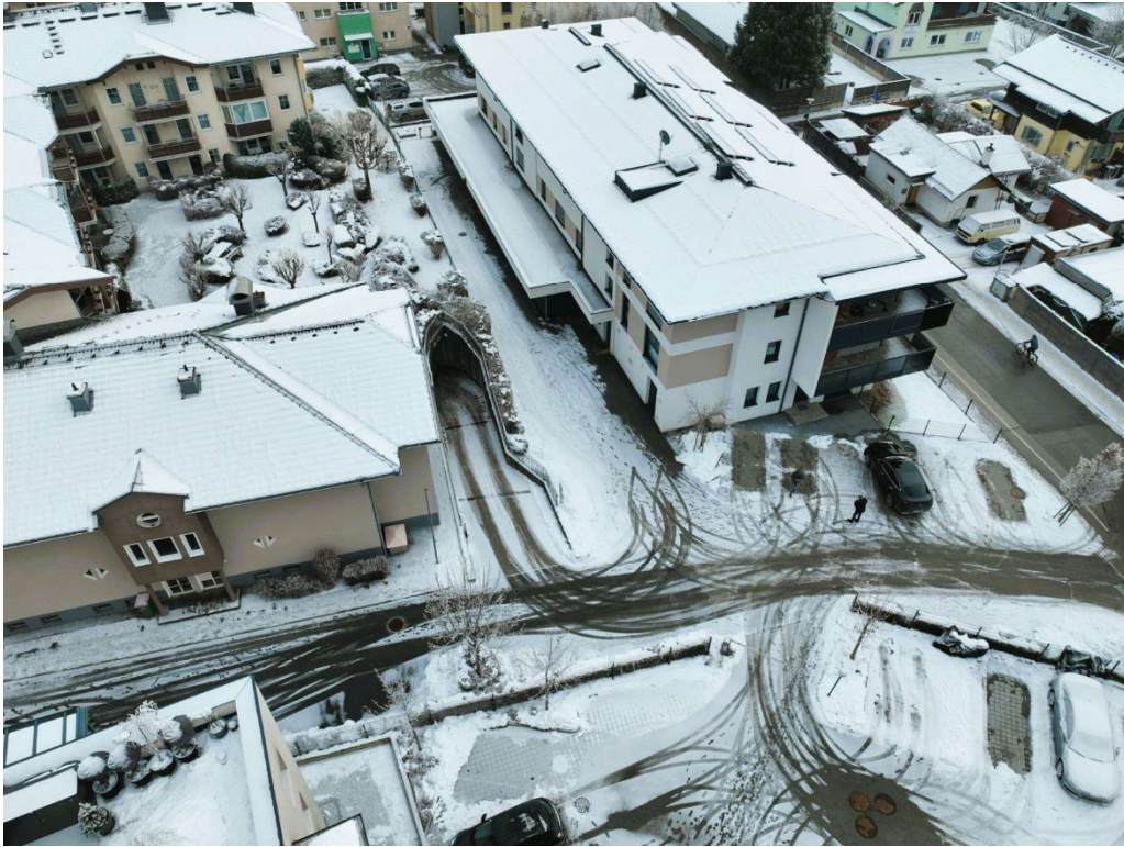
Luftaufnahme von Nordosten mit PKW-Parplätzen im Freien
