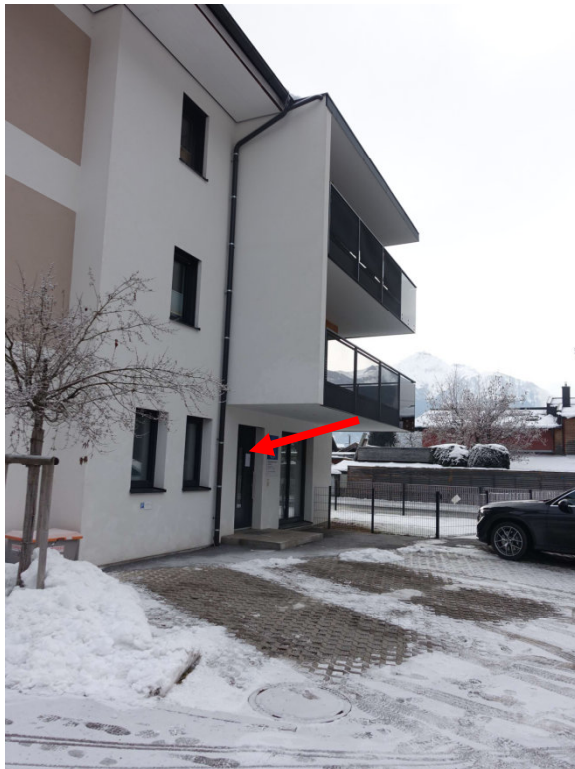
Ansicht von Nordwesten mit Eingang Wohnung Top W01
