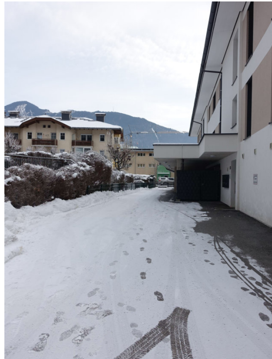
Ansicht von Nordosten mit PKW-Parkplätzen im Freien
