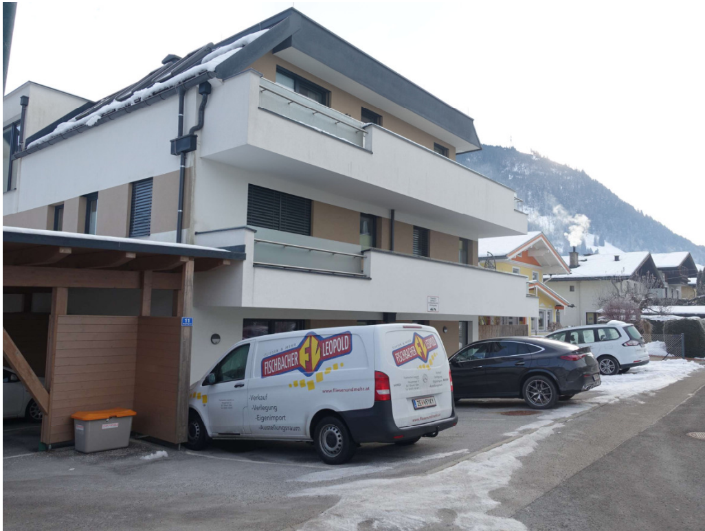
Ansicht Obj. Stegfeldgasse 11 von Nordwesten mit PKW-Parkplätzen im Freien
