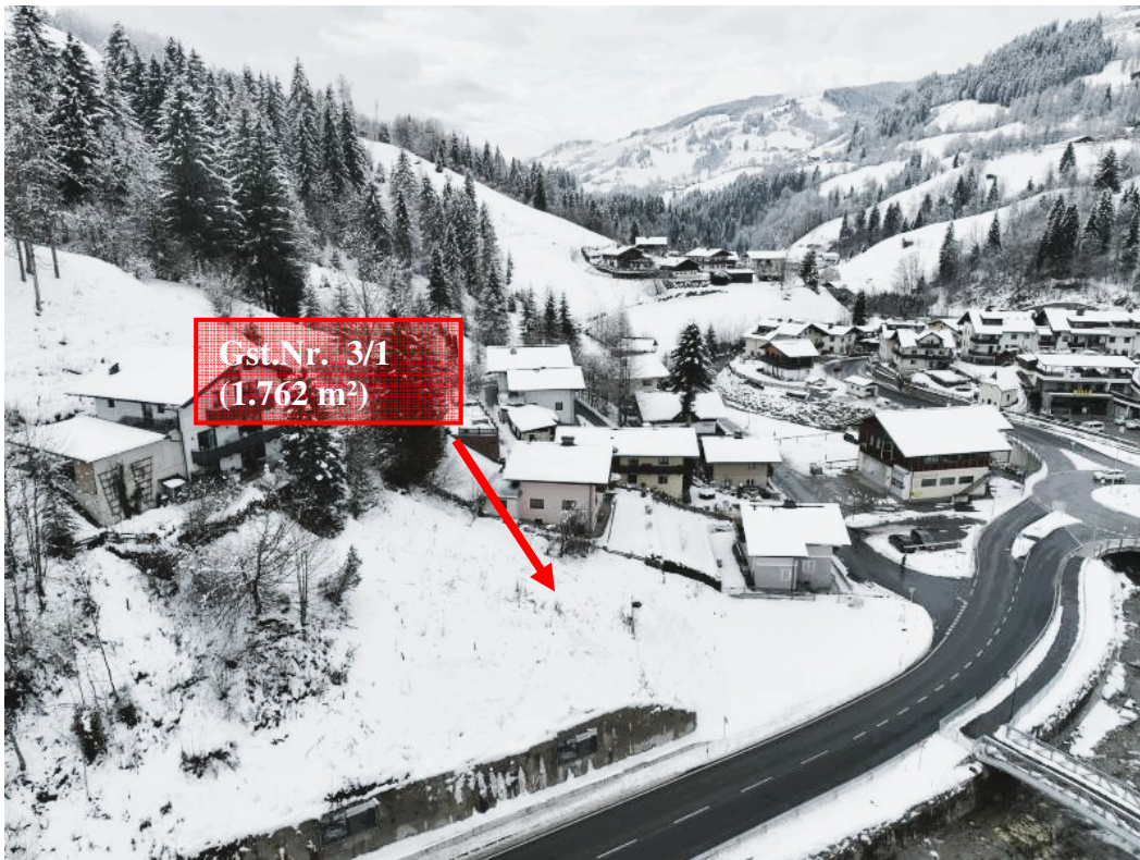
Luftaufnahme von Osten, rechts unten Erschließungsstraße (neue Umfahrung)
