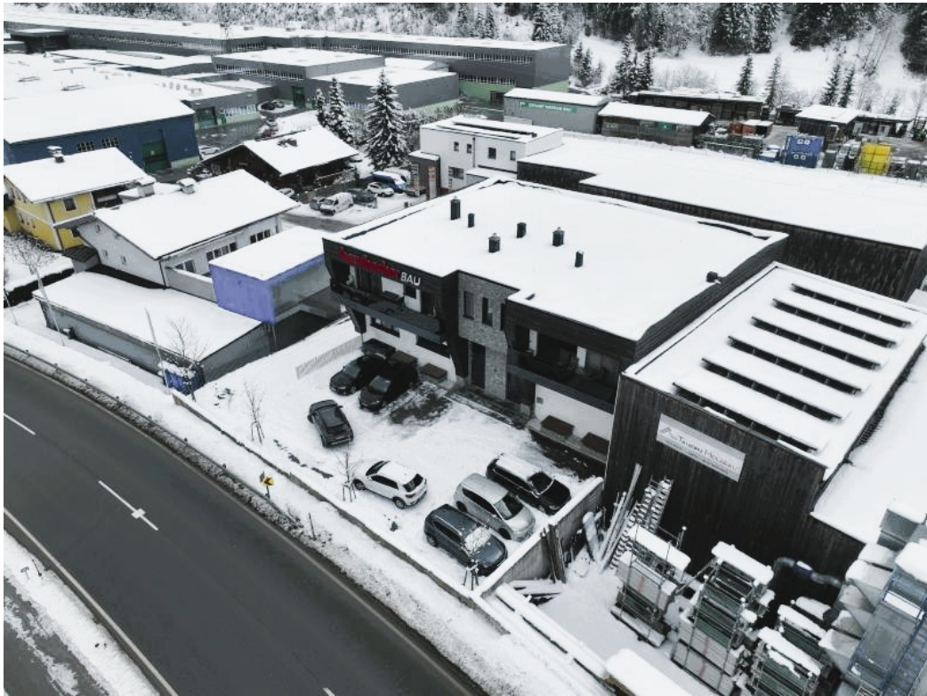
Luftaufnahme von Nordwesten, Bürotrakt im Hintergrund
