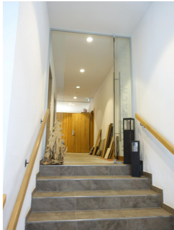
Stiegenaufgang Bürotrakt EG
