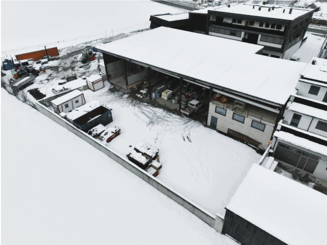
Luftaufnahme Lagergebäude von Südosten, Bürotrakt im Hintergrund
