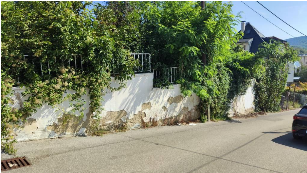
965.jpeg Blick aufs Grundstück (Befestigung zur Straße)
