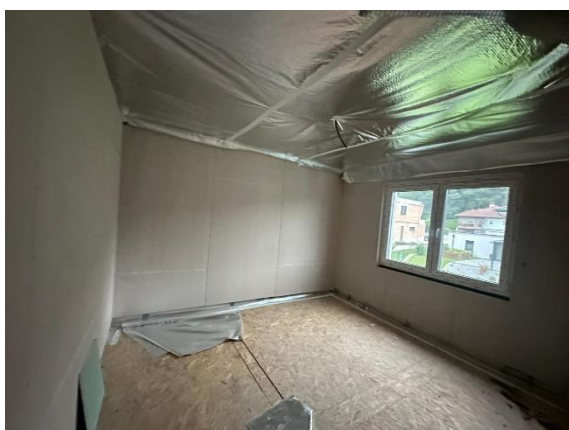
Foto 9: Innenraum im Ausbauzustand
