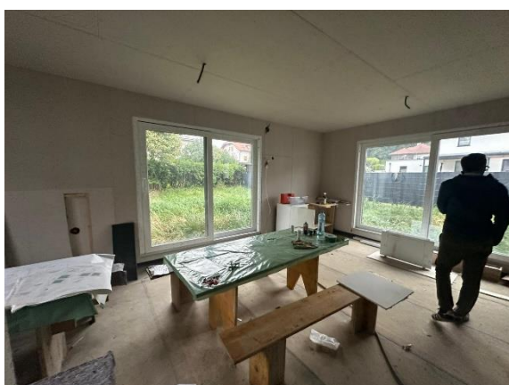
Foto 5: Innenraum im Ausbauzustand
