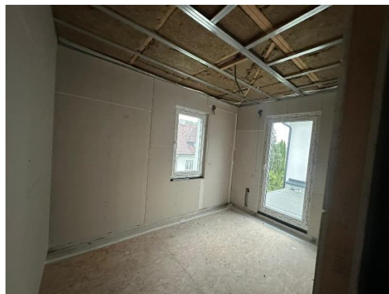
Foto 8: Innenraum im Ausbauzustand
