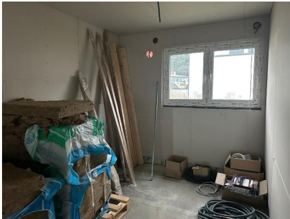
Foto 7: Innenraum im Ausbauzustand
