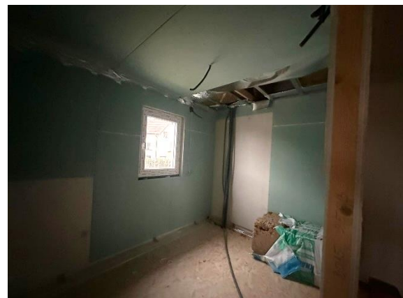
Foto 12: Innenraum im Ausbauzustand
