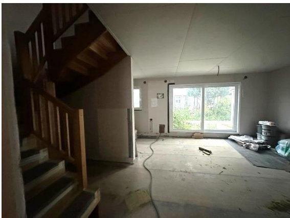
Foto 5: Innenraum im Ausbauzustand
