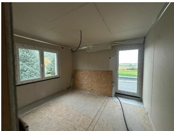
Foto 11: Innenraum im Ausbauzustand
