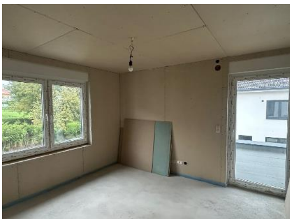
Foto 5: Innenraum im Ausbausezustand
