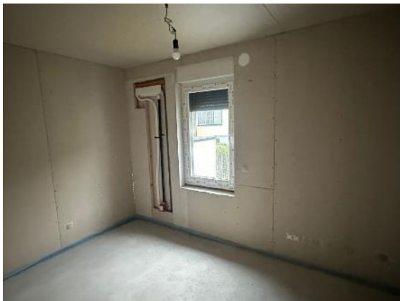
Foto 3: Innenraum im Ausbausezustand
