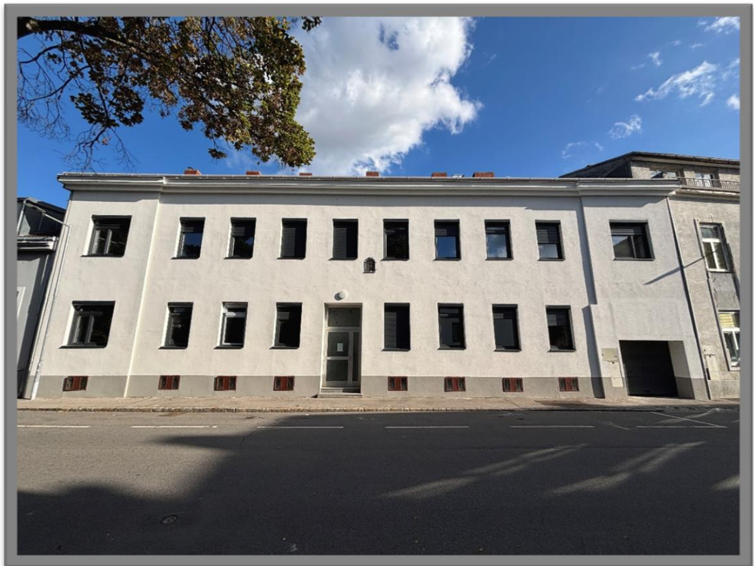
Foto 01: Fassade Straßentrakt Tiefenbachergasse
