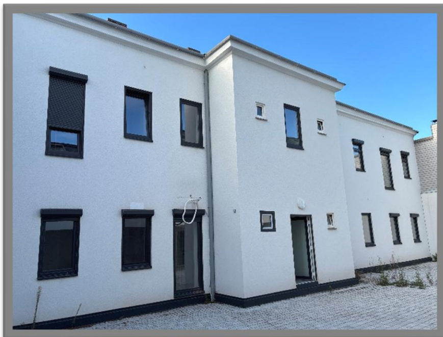
Foto 48: Fassade Rückseite Straßentrakt
