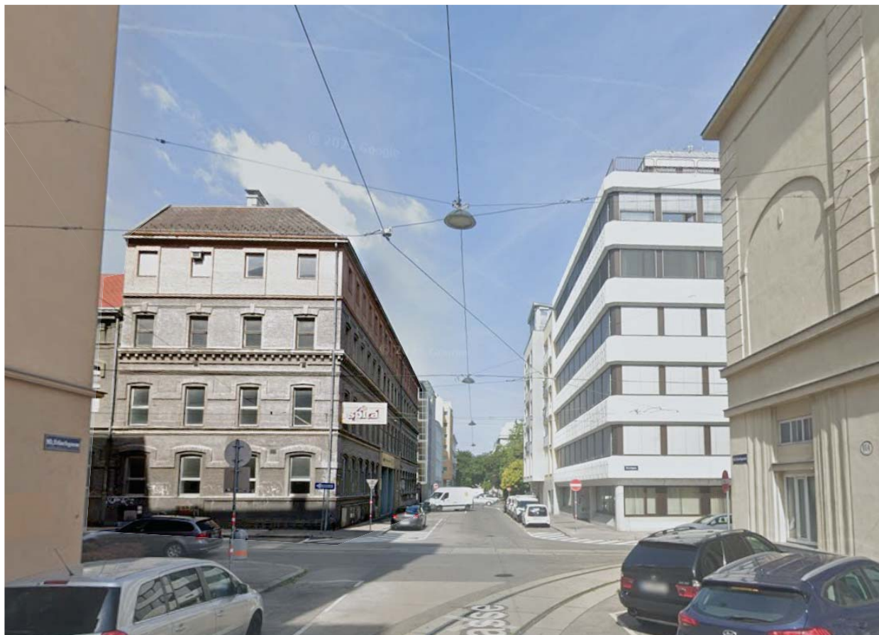
NORDOSTECKE nach WESTEN entlang ERLACHGASSE
