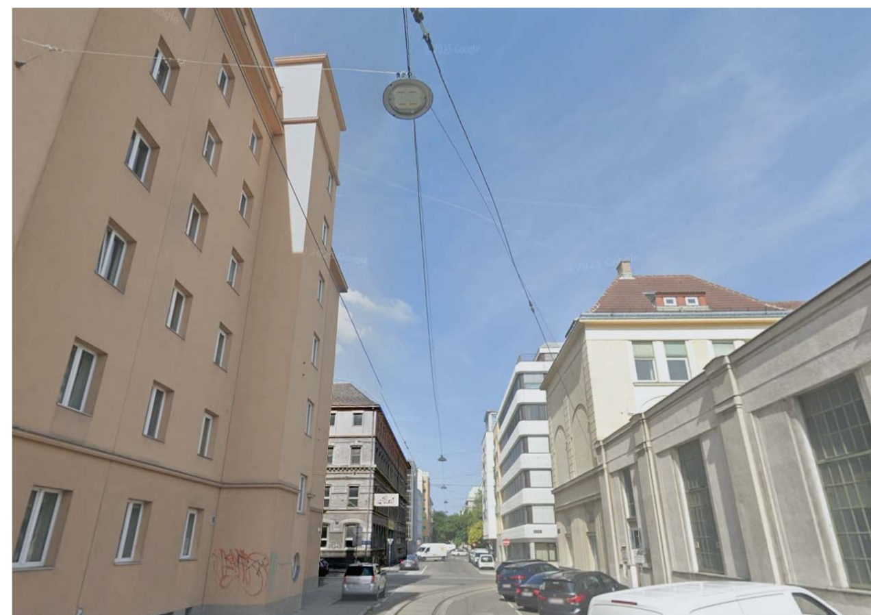
NORDOSTECKE nach WESTEN entlang ERLACHGASSE
