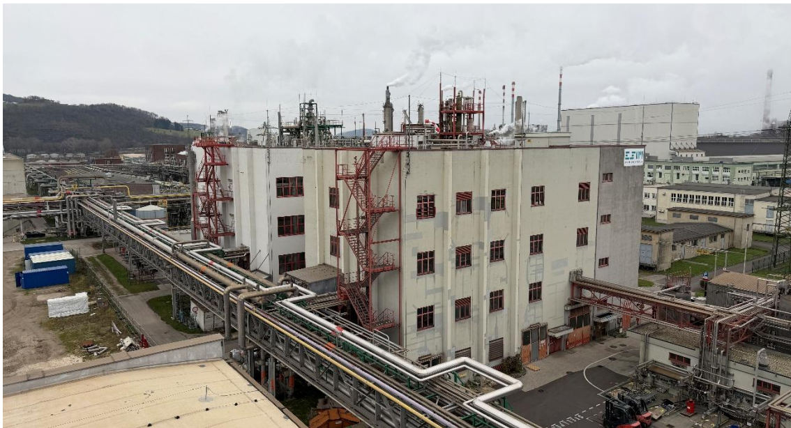
Blick vom Bau 552 auf die Objekte 550 + 551
