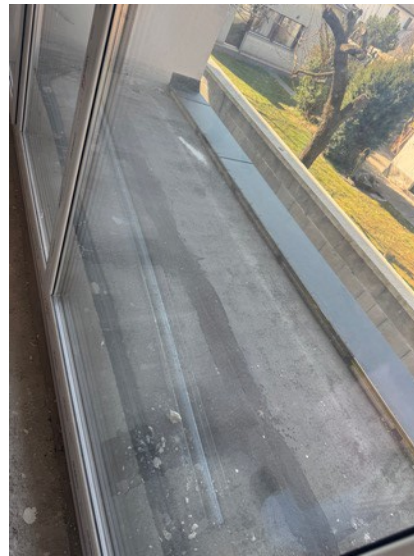
1.OG Top 3 – Balkon Abdichtung
