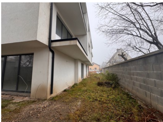
Westansicht Erdgeschoß – Vorgarten, Blickrichtung Süd
