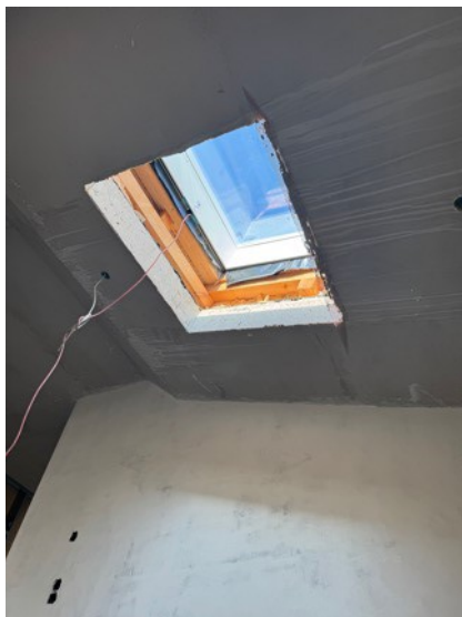
DG Stiegenhaus, Dachfenster
