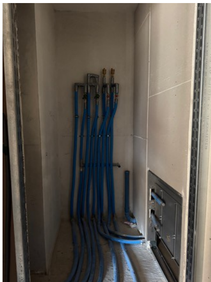
Erdgeschoss Top 2 – „WC“
