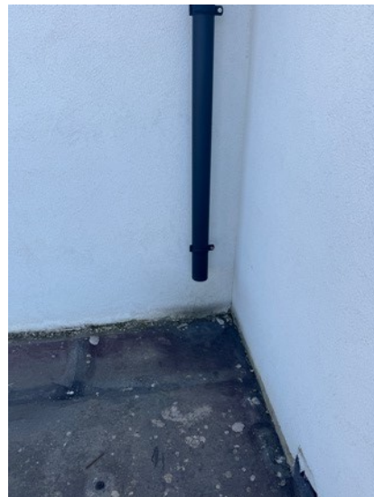
DG Top 9 – Terrasse, Regenabflussrohr
