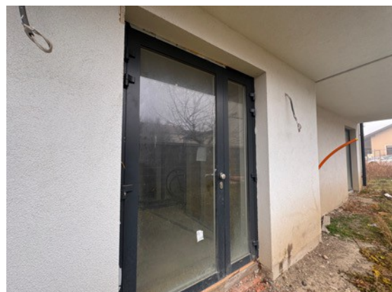
Hauseingang / Zugang Stiegenhaus
