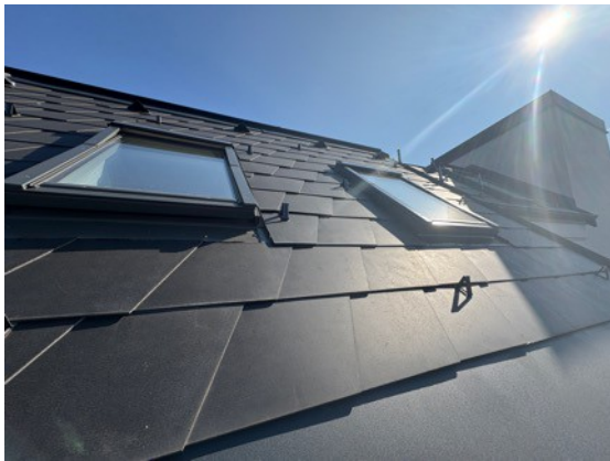
DG Top 9 – Dachdraufsicht
