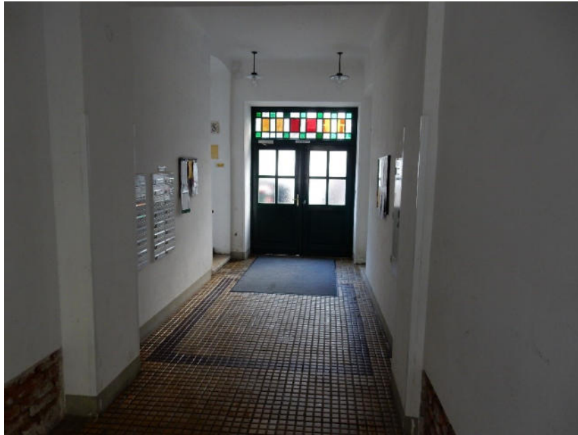
Foto 3: Hauseingangsbereich / Durchgang zum Innenhof
