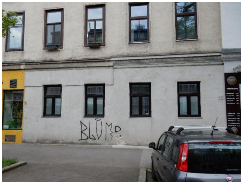
Foto 20: GL 4 und GL 5-6 Fenster statt der planmäßig straßenseitigen Eingänge in der Steinbauergasse zu den GL 4 und GL 5-6
