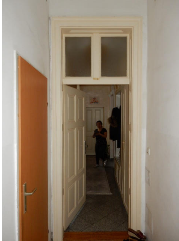
Foto 15: Eingang zum GL 5-6 (mit GL 4 zusammengelegt / als Wohnung genutzt))
