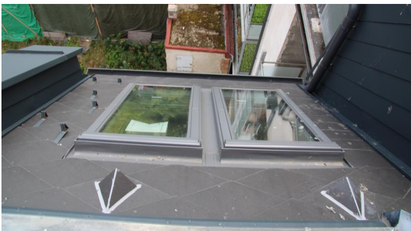
Die Schrägdachdeckung erfolgte mittels Eternit-Rhombusschindeln.
