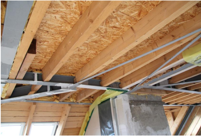
Die Terrassen sind isoliert, die Geländer montiert.
