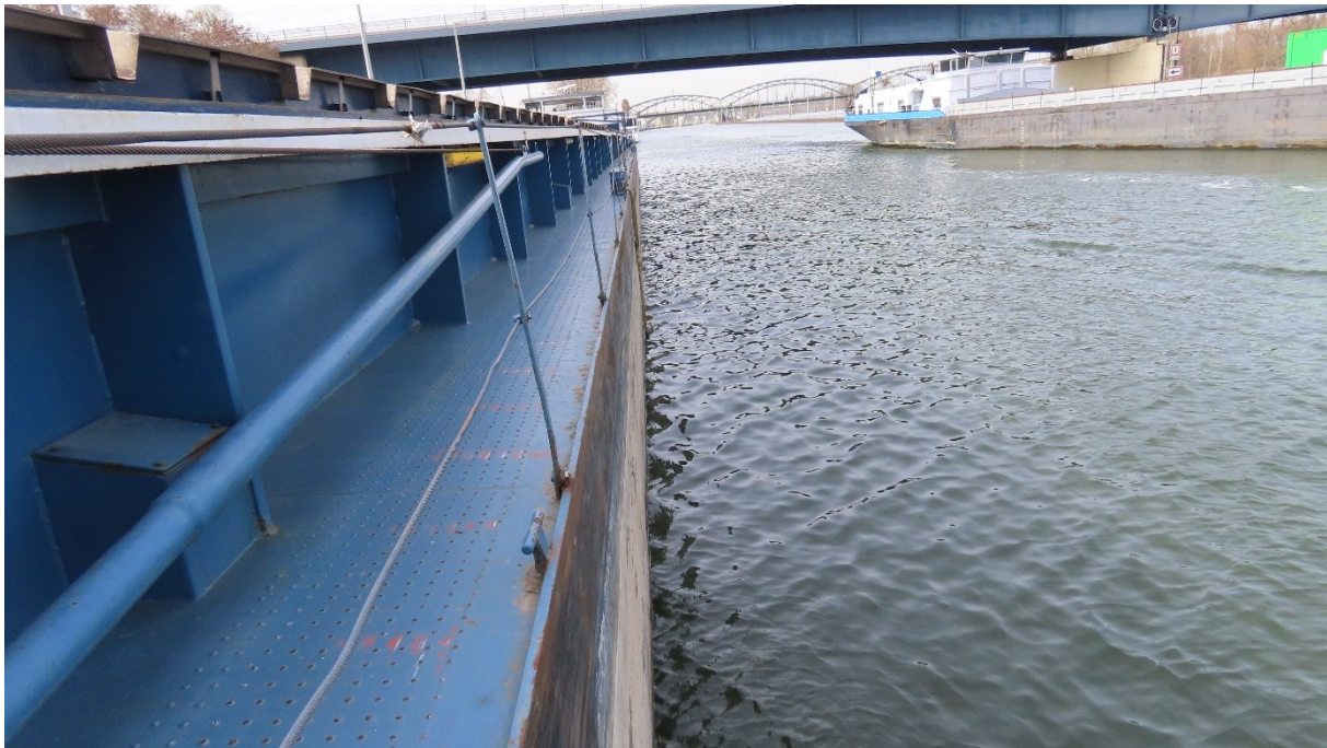
Abbildung 92 Sicht auf die Bb.-seitige Außenhülle vom Gang Bord aus in Blickrichtung Hinterschiff
