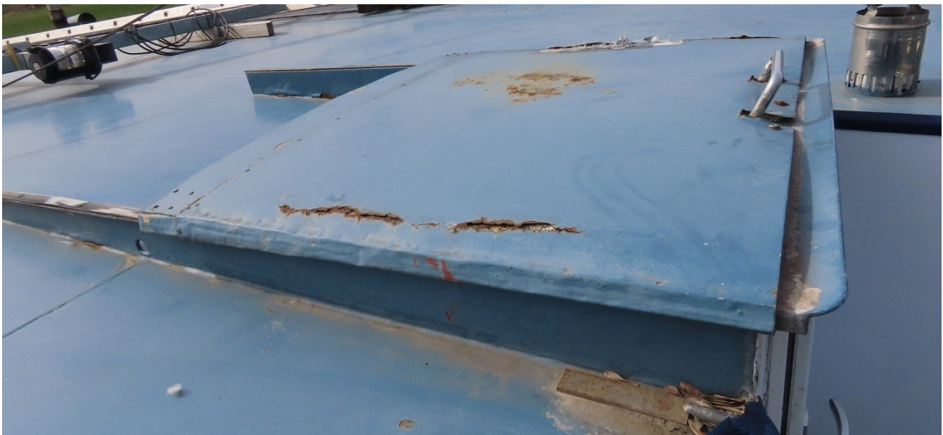
Abbildung 79 Einstiegluke der Vorschiffswohnung starker Rostbefall
