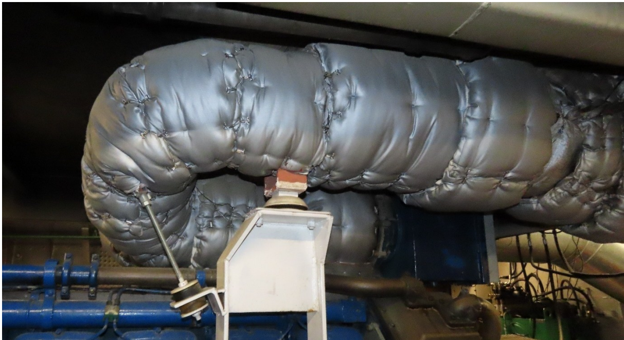
Abbildung 29 keine Schadstellen in der Isolierung
