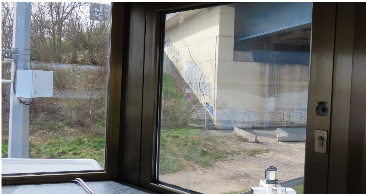
Abbildung 13 Riss in der stb.-seitigen Fensterscheibe (ehemalige Tür), Fenstergriff abgebrochen
