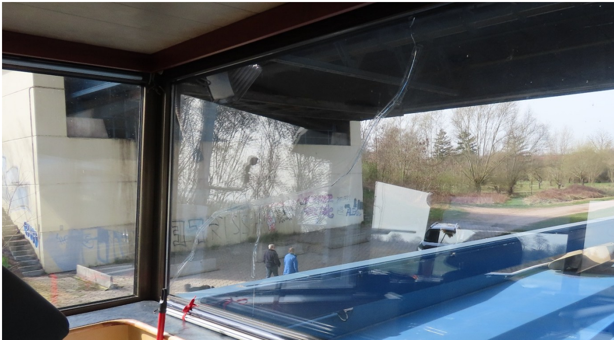
Abbildung 14 Riss durch die gesamte Doppelverglasung im stb.-seitigen hinteren Fenster
