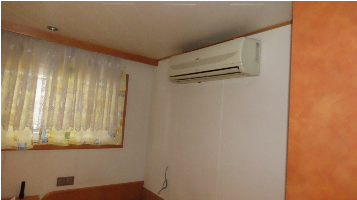
Abbildung 78 mittlere Schlafkammer mit Klimaanlage und fehlender Wandleuchte
