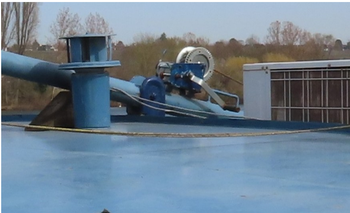
Abbildung 58 Handkurbel zur Höhenverstellung
