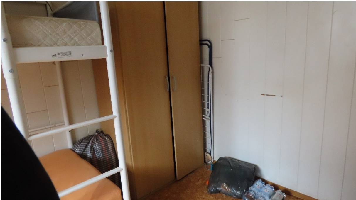
Abbildung 86 Innenverschalung gebrochen, Schrank verzogen und schließt nicht mehr
