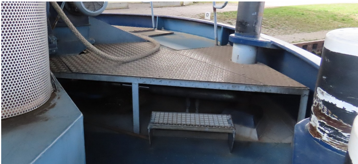
Abbildung 35 Abdeckungen des Ruderquadrantenraum
