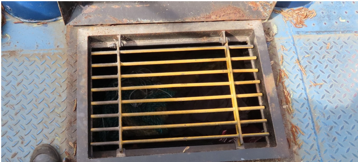
Abbildung 60 Zugangsluke Vorpiek mit Klappdeckel und eingesetztem Gitter
