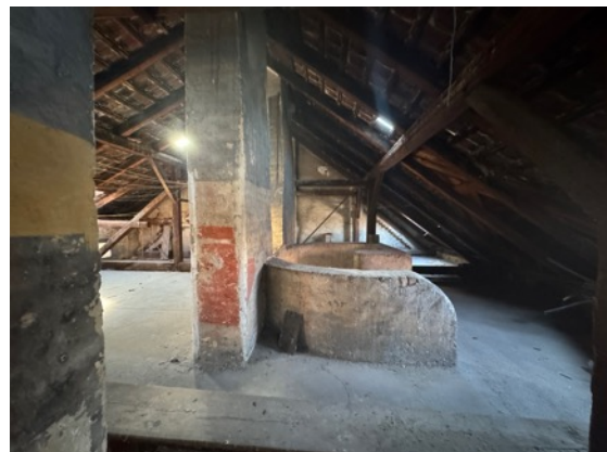
Gebäudeteil Davidgasse inkl. Stiegenaufgang
