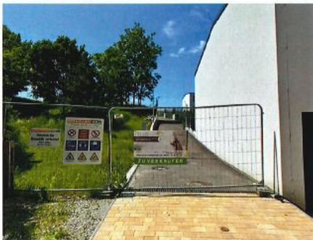
Foto 3: Zufahrt Doppelhäuser | Erschließungsstraße
