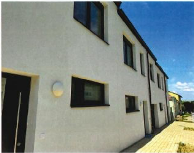
Foto 1: Ansicht Bründlgasse | Reihenhäuser
