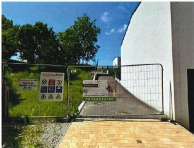
Foto 3: Zufahrt Doppelhäuser | Erschließungsstraße
