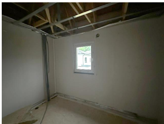
Foto 6: Innenraum im Ausbauzustand
