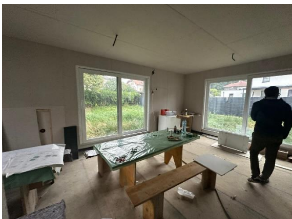
Foto 5: Innenraum im Ausbauzustand
