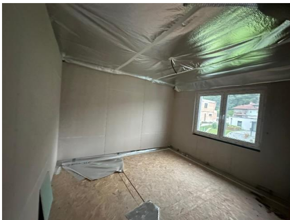
Foto 9: Innenraum im Ausbauzustand
