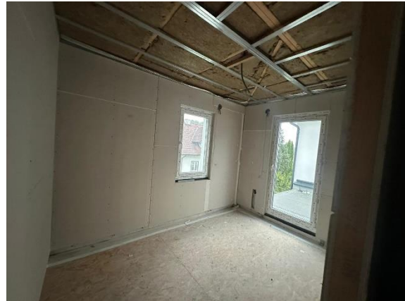
Foto 8: Innenraum im Ausbauzustand
