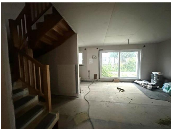
Foto 5: Innenraum im Ausbauzustand
