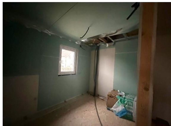
Foto 12: Innenraum im Ausbaurzustand
