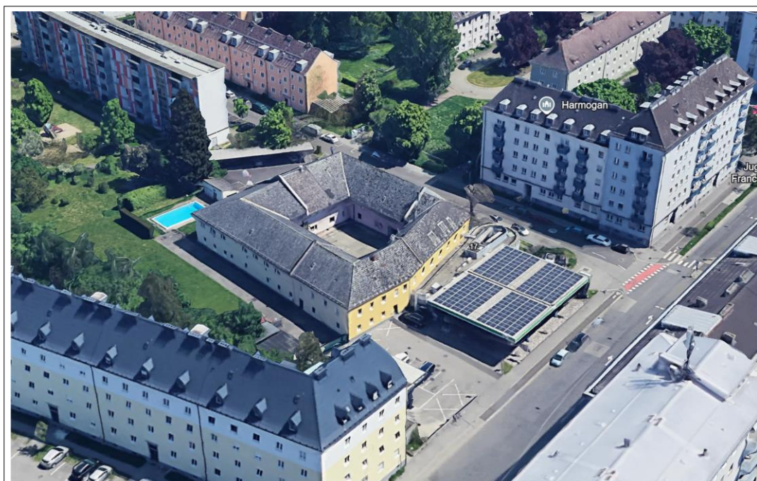
PV-Anlage (Quelle: earth.google.com )
