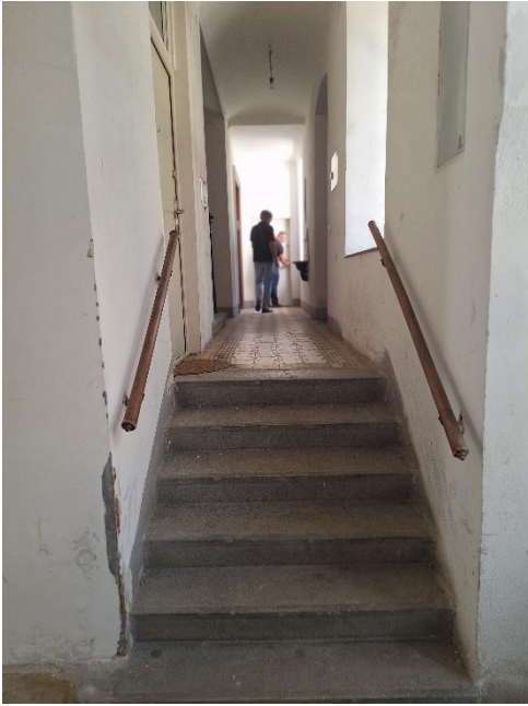
Foto 26 Zugang zu Top 5
