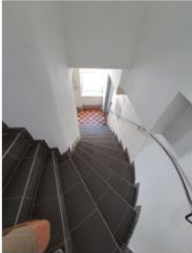
Zugang Top 21 und 22 allgemeine Teile
