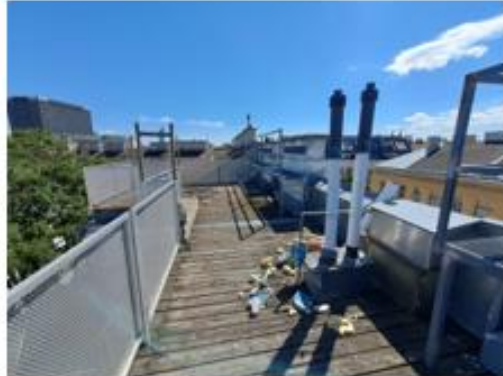
Dachterrasse allgemeiner Teil
