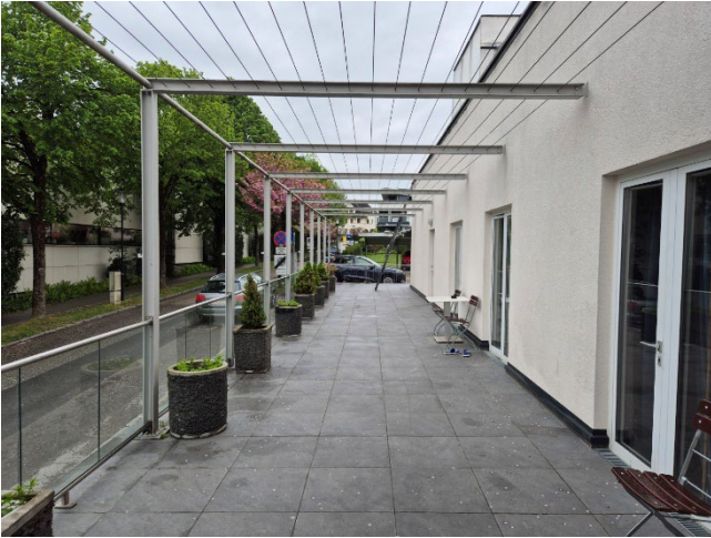
Abbildung: Zugang zu den Wohneinheiten
