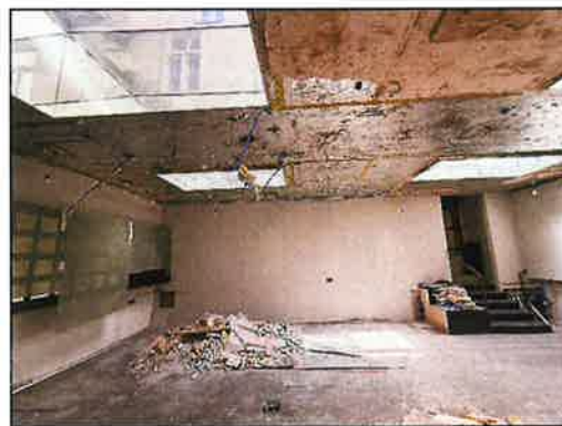
Sanierungsarbeiten Geschäftslokal Wasserschaden
