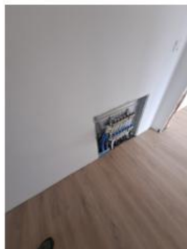
Fußbodenheizung Verteiler
