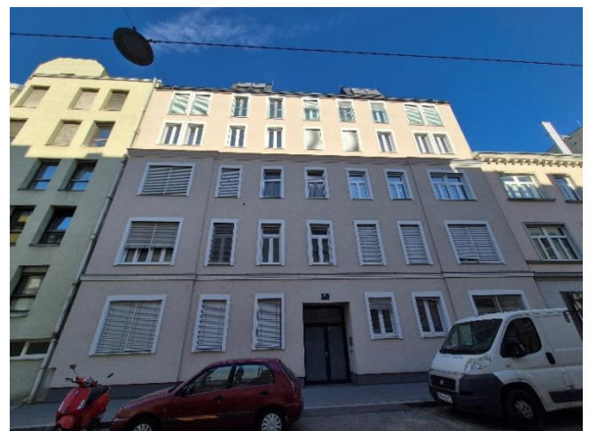
Abbildung: Zugang zur Liegenschaft
