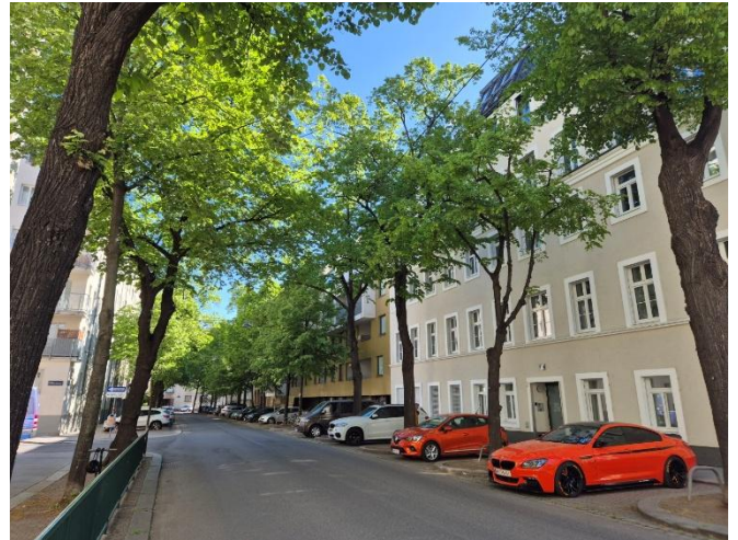
Abbildung: Ansicht Liegenschaft Petrusgasse (Blick: Richtung Nordosten)
