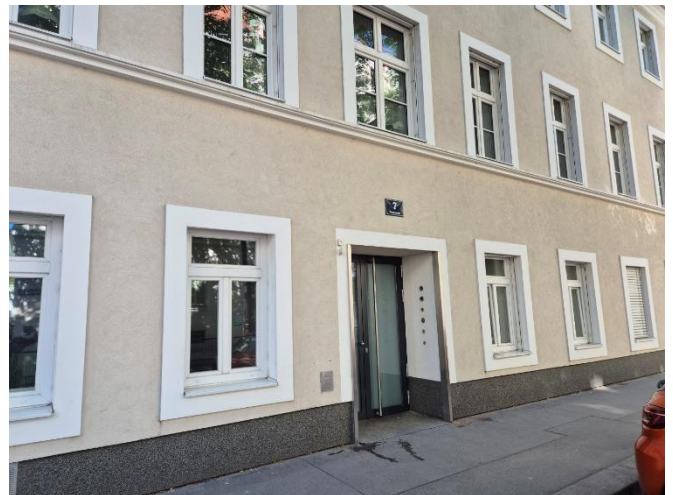
Abbildung: Zugang zur Liegenschaft Petrusgasse
