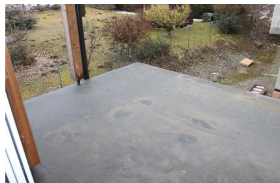
Bild 5: Terrasse, Dämmung und Feuchteabdichtung fertiggestellt, Absturzsicherung fehlt
