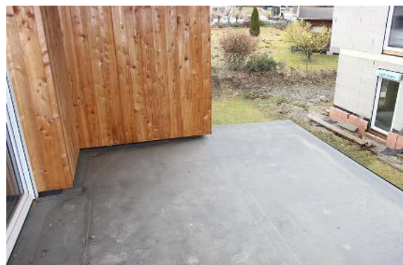
Bild 6: Loggia, Dämmung und Feuchteabdichtung fertiggestellt, Absturzsicherung fehlt
