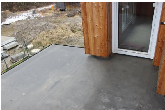
Bild 5: Loggia, Dämmung und Feuchteabdichtung fertiggestellt, Absturzsicherung fehlt
