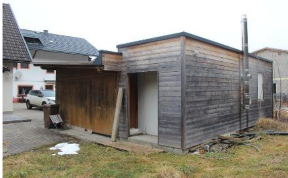
Bild 11: Übersichtsbilde – Heizhaus für Pelletsheizung
