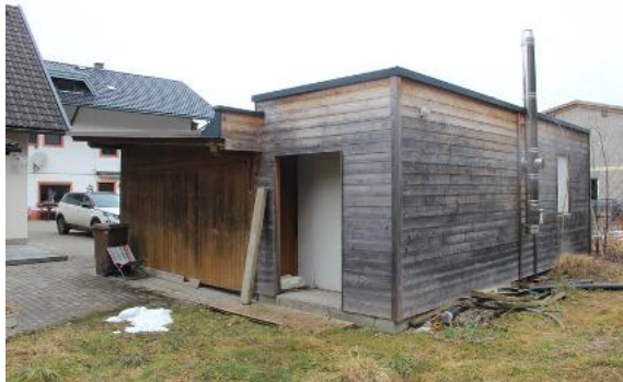
Bild 7: Übersichtsbilde – Heizhaus für Pelletsheizung
