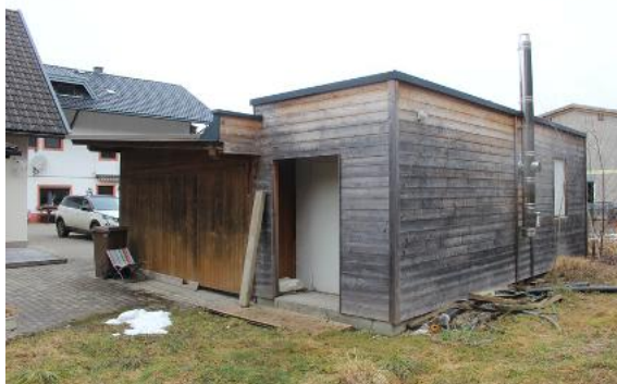
Bild 3: Übersichtsbilde – Heizhaus für Pelletsheizung
