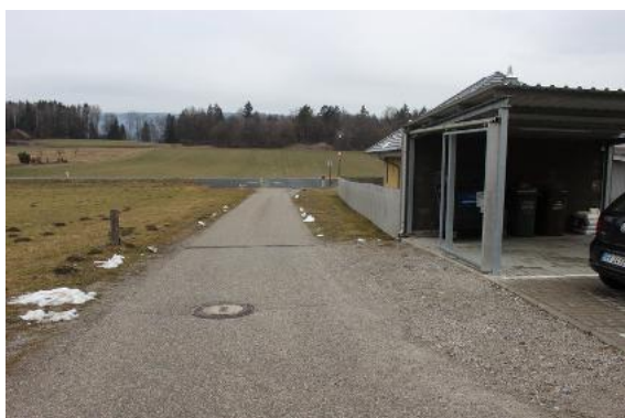
Bild 9: Zufahrtbereich mit noch fehlenden Längsparkplätzen
