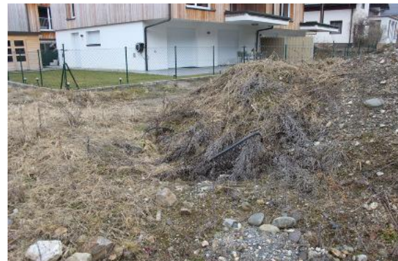
Bild 4: Kanal-, Wasser- und Stromanschluss
