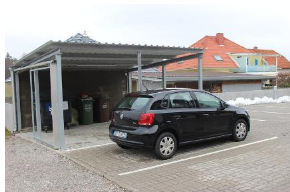
Bild 14: Müllinsel – fertig gestellt
