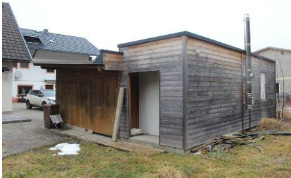
Bild 7: Übersichtsbilde – Heizhaus für Pelletsheizung
