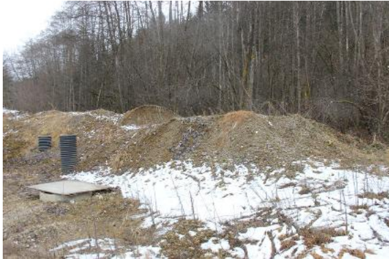
Bild 5: Im Bereich der Gebäude D und E befindet sich noch Aushubmaterial, welches zu entsorgen ist - geschätztes Volumen ca. 2.500 m³
