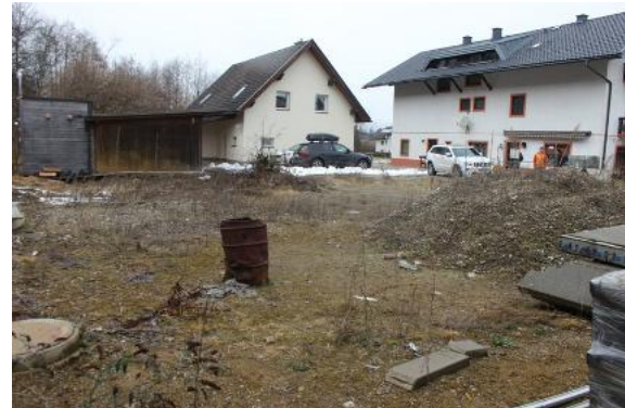
Bild 2: 1 Mit dem Bau des Gebäudes Haus D wurde noch nicht begonnen.
