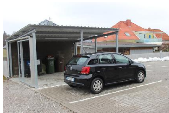
Bild 14: Müllinsel – fertig gestellt
