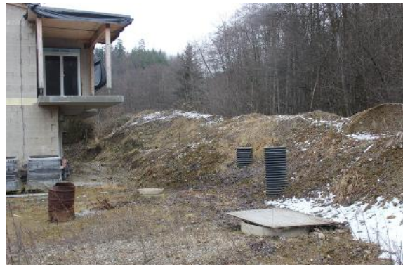
Bild 6: Im Bereich der Gebäude D und E befindet sich noch Aushubmaterial, welches zu entsorgen ist - geschätztes Volumen ca. 2.500 m³
