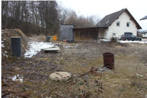
Bild 1: Mit dem Bau des Gebäudes Haus D wurde noch nicht begonnen.
