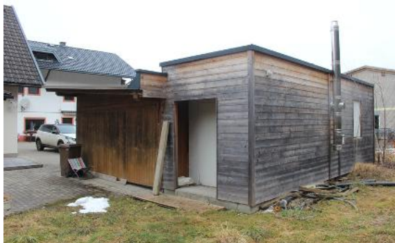
Bild 7: Übersichtsbilde – Heizhaus für Pelletsheizung
