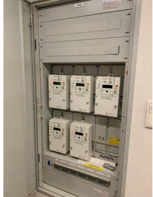
Bild 26 von 32 Blick in den Zählerkasten außerhalb der Wohneinheit
