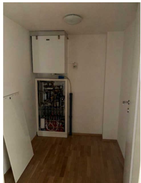
Bild 20 von 32 Blick in den Schrankraum
