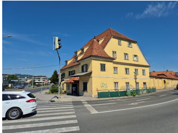
Abbildung: Blick auf die Liegenschaft Ecke Grabenstraße / Andritzer Reichsstraße
