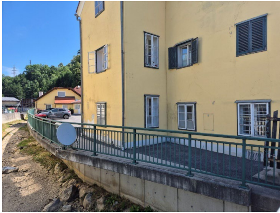
Abbildung: Nordansicht der Liegenschaft
