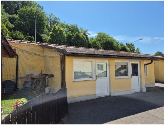
Abbildung: Nebengebäude (Lager / Fahrradraum)
