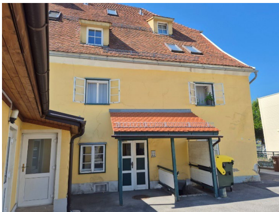
Abbildung: Hausrückseite / Zugang Wohnungen
