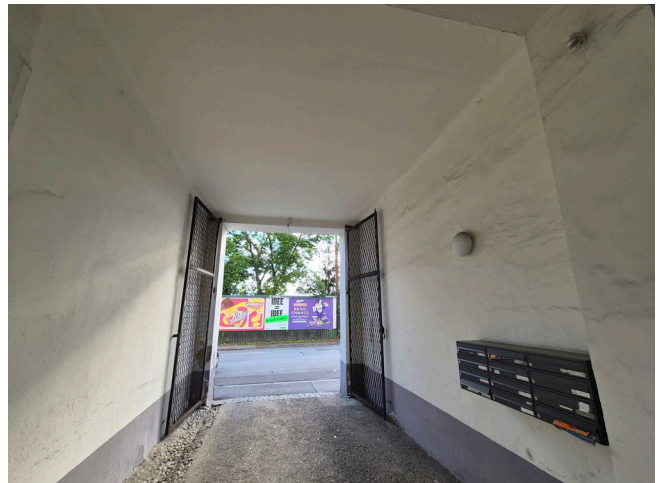
Abbildung: Durchfahrt – Blick Richtung Münzgrabenstraße
