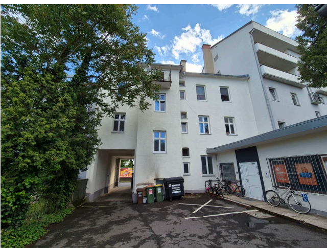
Abbildung: hofseitige Fassade
