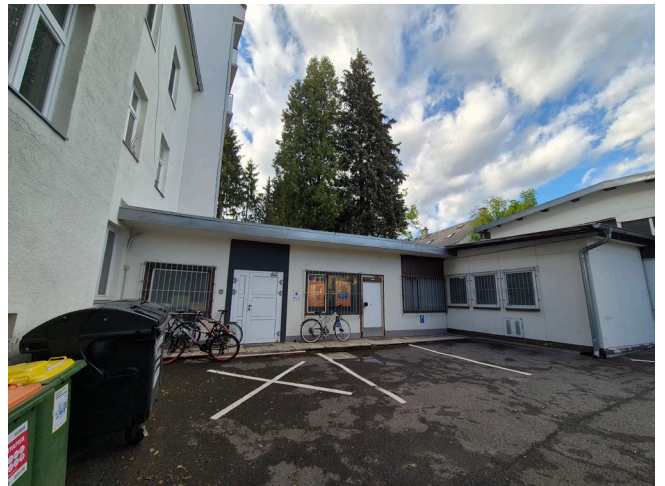
Abbildung: Ansicht Hofgebäude
