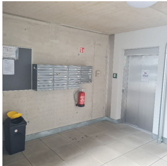
Abbildung: Postkästen und Lift Haus 2
