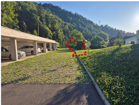
Abbildung: Stellplätze, nicht vorhandenen Stellplätze AP-F01 und Besucherstellplatz= roter Pfeil
