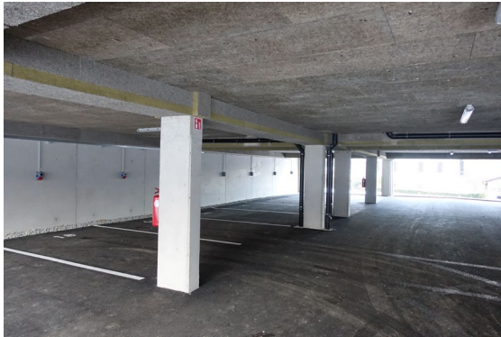
Abbildung: Kfz-Abstellplätze unter Dach
