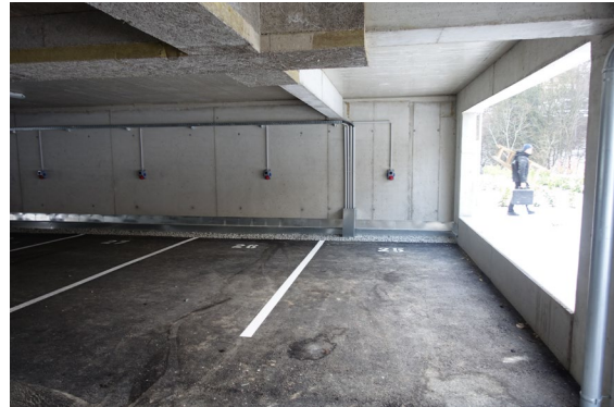
Abbildung: Kfz-Abstellplätze unter Dach
