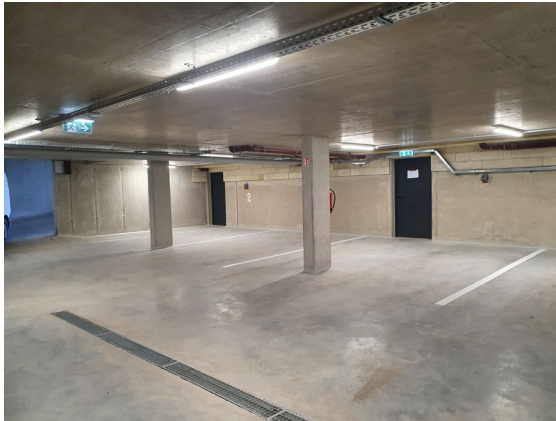
Abbildung: Tiefgarage, Kfz-Abstellplätze
