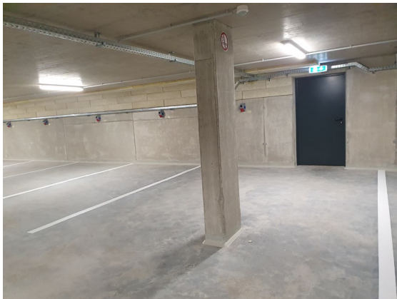
Abbildung: Tiefgarage, Kfz-Abstellplätze
