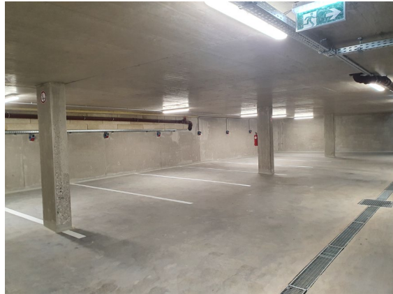
Abbildung: Tiefgarage, Kfz-Abstellplätze
