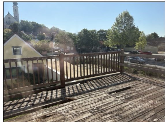
Balkon Büro 1. OG
